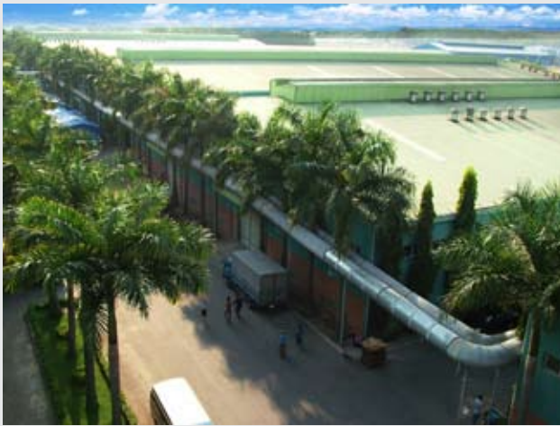
Hệ thống xử lý bụi tại nhà máy của TTF
